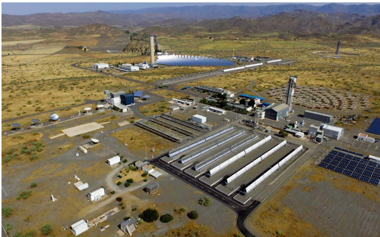
Figura 2. Vista aérea de la PSA.
