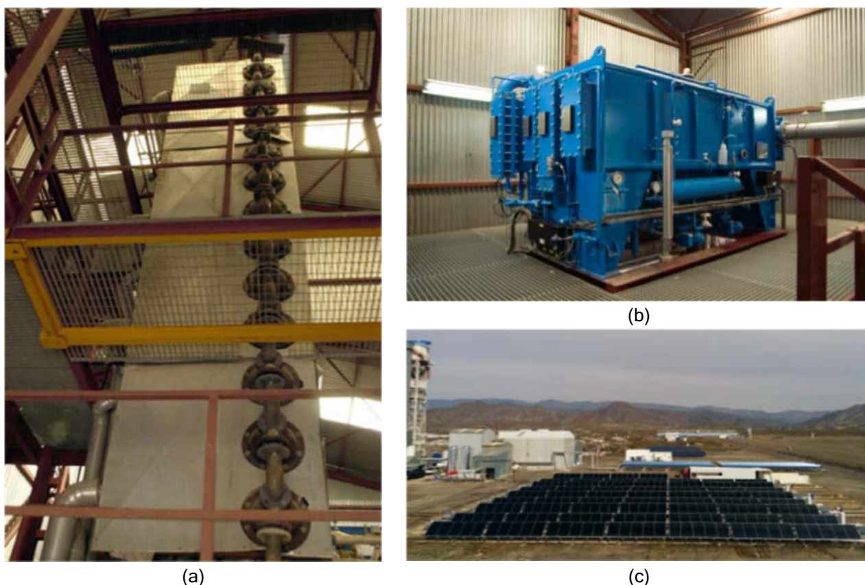
Figura 36. La planta MED SOL-14 de la PSA (a) bomba de absorción de calor de doble efecto LiBr-H 2 O (b) y campo de 606-m 2 de captadores solares estáticos (c).
