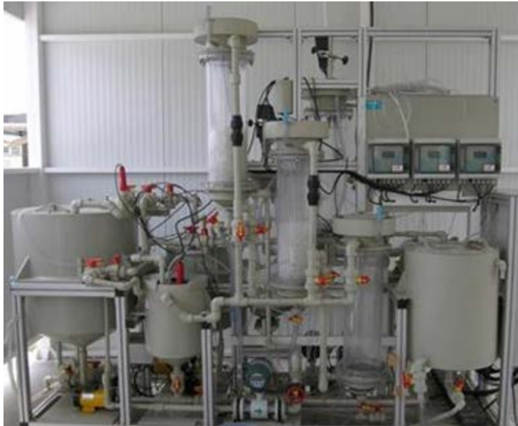
Figura 53. Planta piloto biológica instalada en la PSA.
