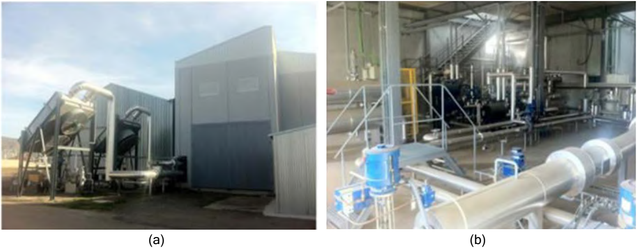
Figura 38. Vista exterior del edificio CSP+D con sus aerocondensadores (a) y vista parcial del interior del banco de ensayo CSP+D (b).
