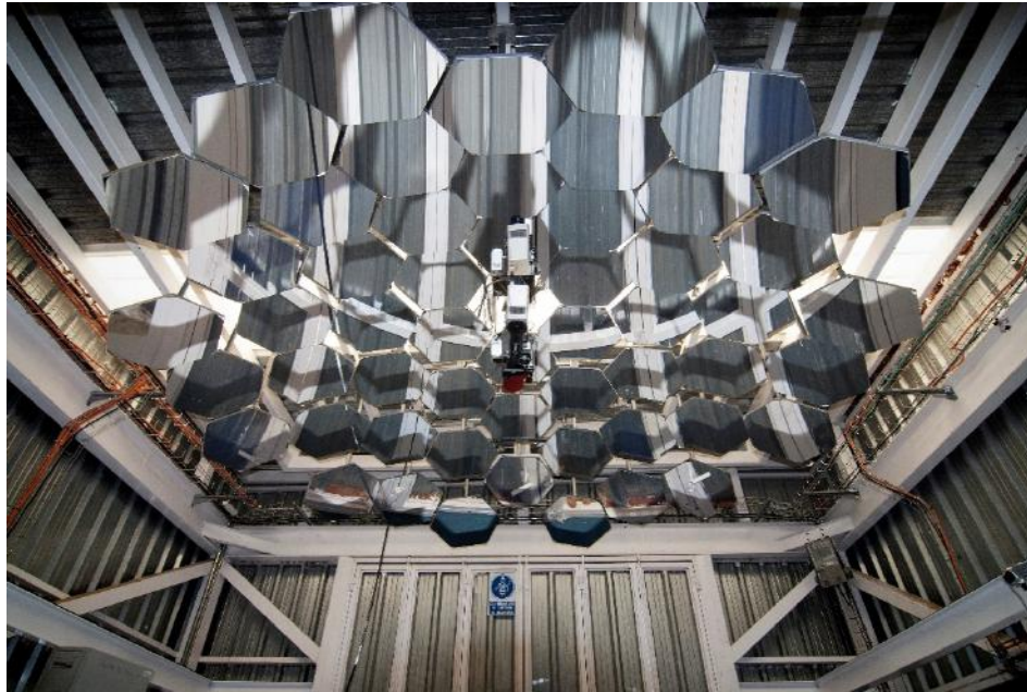
Figura 32. Captador del horno solar SF-5.
