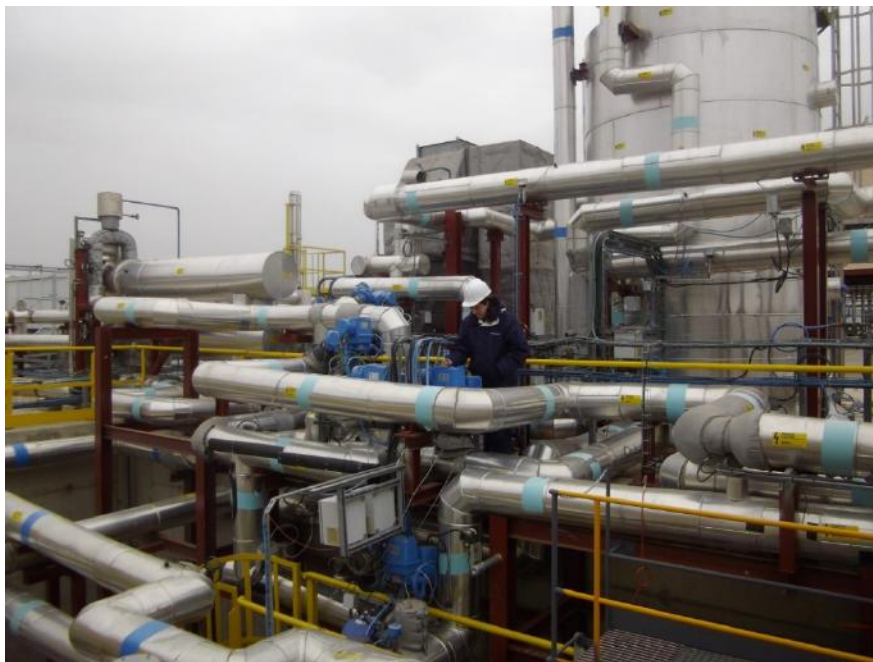
Figura 18. Lazo de ensayos exterior de sales fundidas (MOSA).
