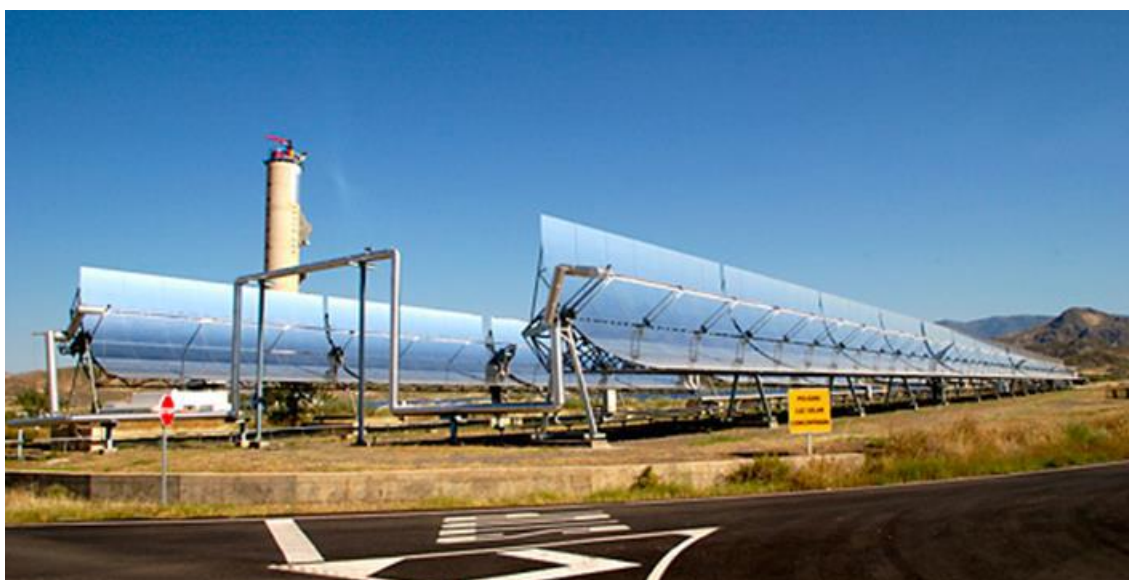
Figura 7. Vista de la planta DISS en funcionamiento.
