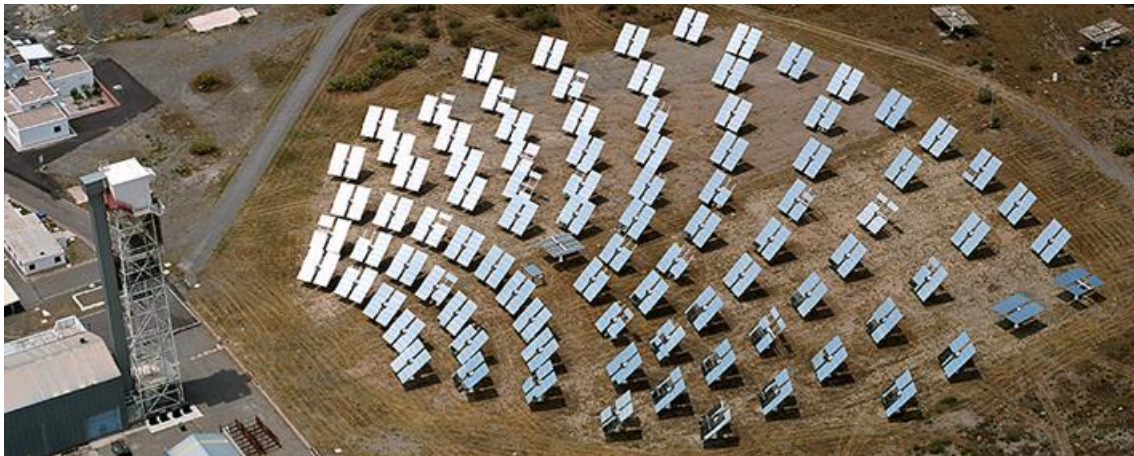
Figura 24. Vista aérea de la instalación experimental SSPS-CRS.
