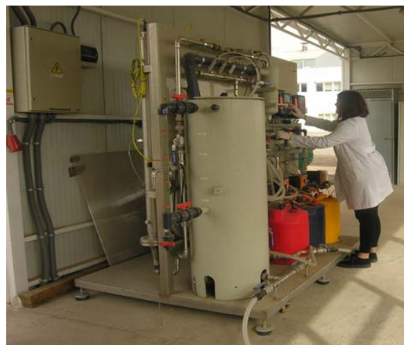
Figura 49. Planta piloto de radiación UVC instalada en la PSA.
