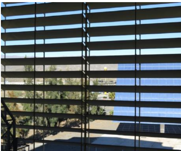
Figura 29. Atenuador del Horno Solar SF-60 de la PSA.
