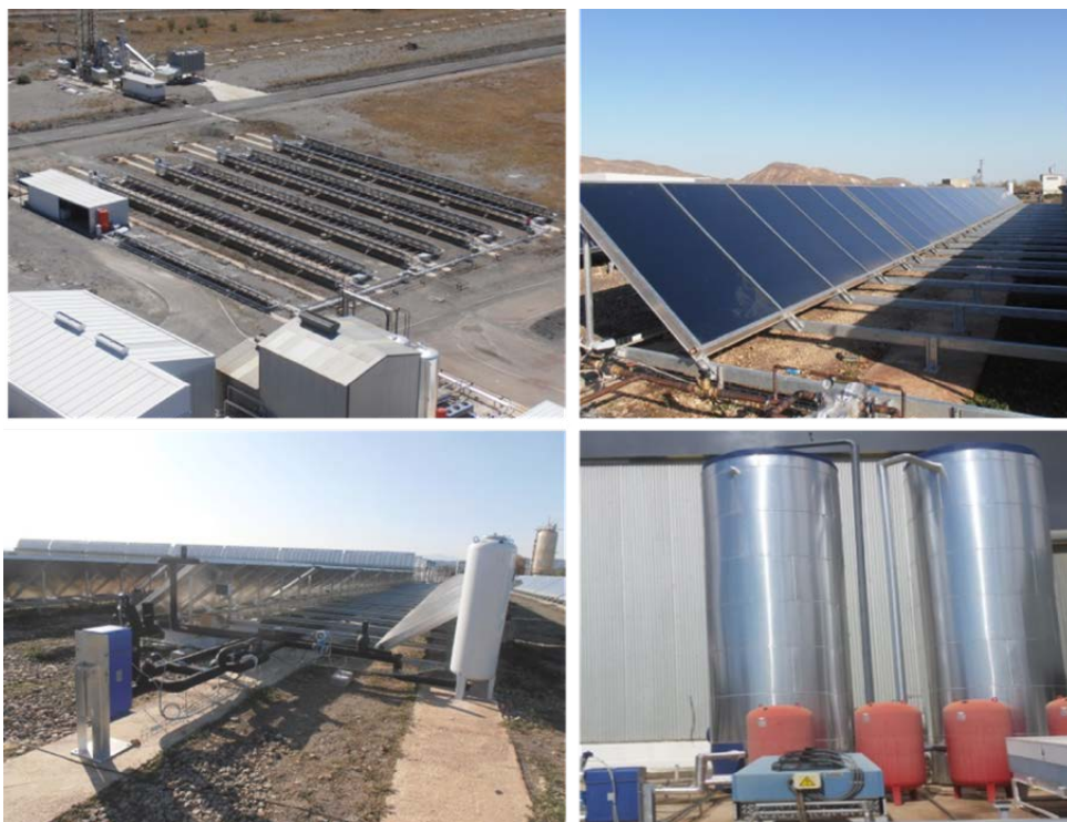
Figura 37. El campo solar de 606-m 2 con captadores de placa plana de gran apertura (AQUASOL-II).
