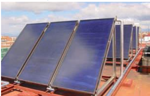
Figura 4.10.12. Colectores planos vidriados, tubo de vacío y no vidriados
