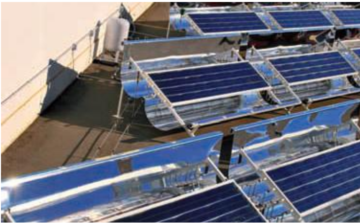
Figura 4.10.13. Colectores de ultra alto vacío (UHV)
