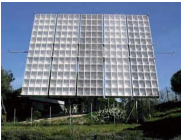
Figura 4.9.9. Instalación solar fotovoltaica de concentración
