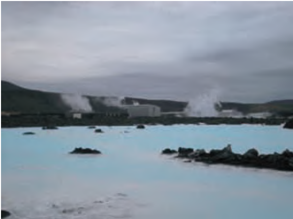
Figura 4.6.6. Central geotérmica y Blue Lagoon en Islandia, Octubre 2010
