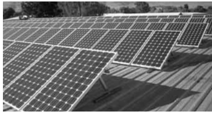
Figura 3.9. Mòduls prefabricats per a l'ancoratge de panells amb contrapès.
